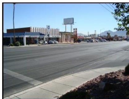
Centros Comerciales de Charleston Blvd.
