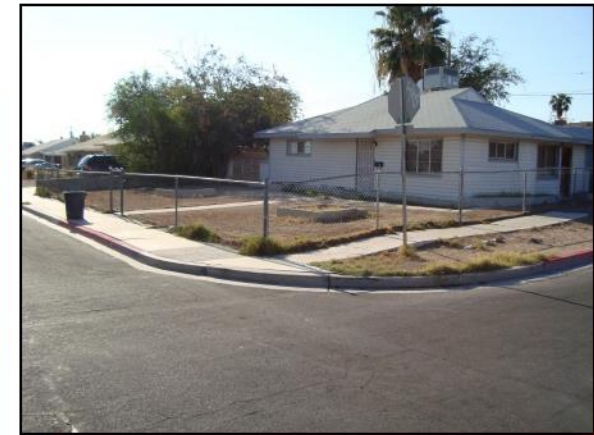
Esquina de las avenidas Crestwood y Franklin sin rampas en las aceras
