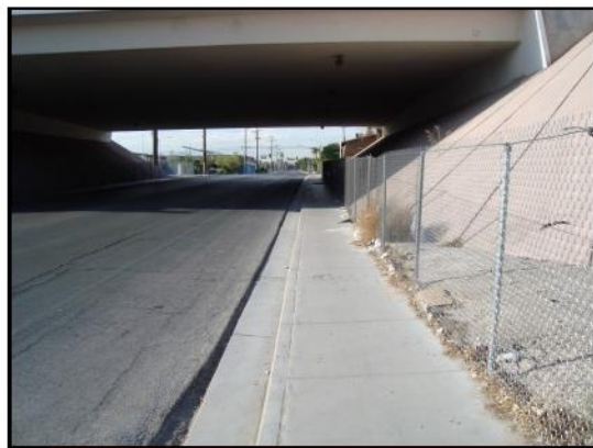
La calle 28 en la Avenida Marlin mirando hacia el sur
