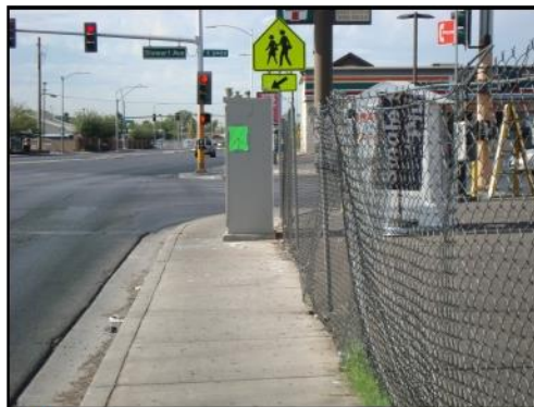
Gabinete de servicios públicos y valla que se entromete en la acera en Eastern Avenue a la altura de Stewart Avenue
