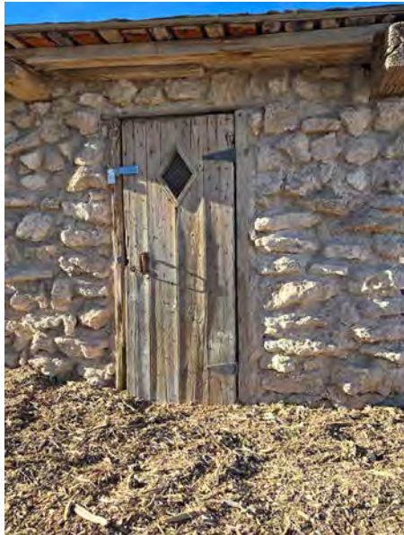
Adobe Hut - SE door detail 11.20.24
