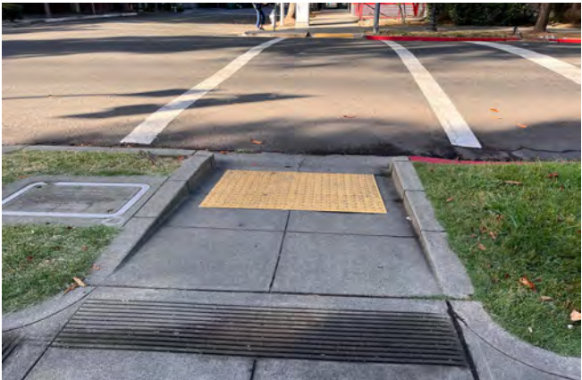
Rampa en la acera y franja táctil de advertencia que conducen al cruce peatonal en una calle local de Sacramento. (Dylan Passmore / Flickr)
